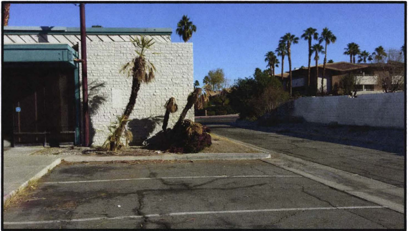
441 S. Calle Encilia – Exterior Conditions
